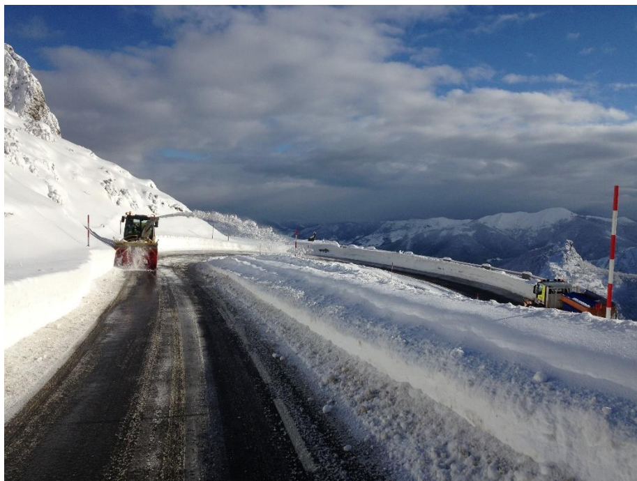
Retirada de nieve en la N-621
