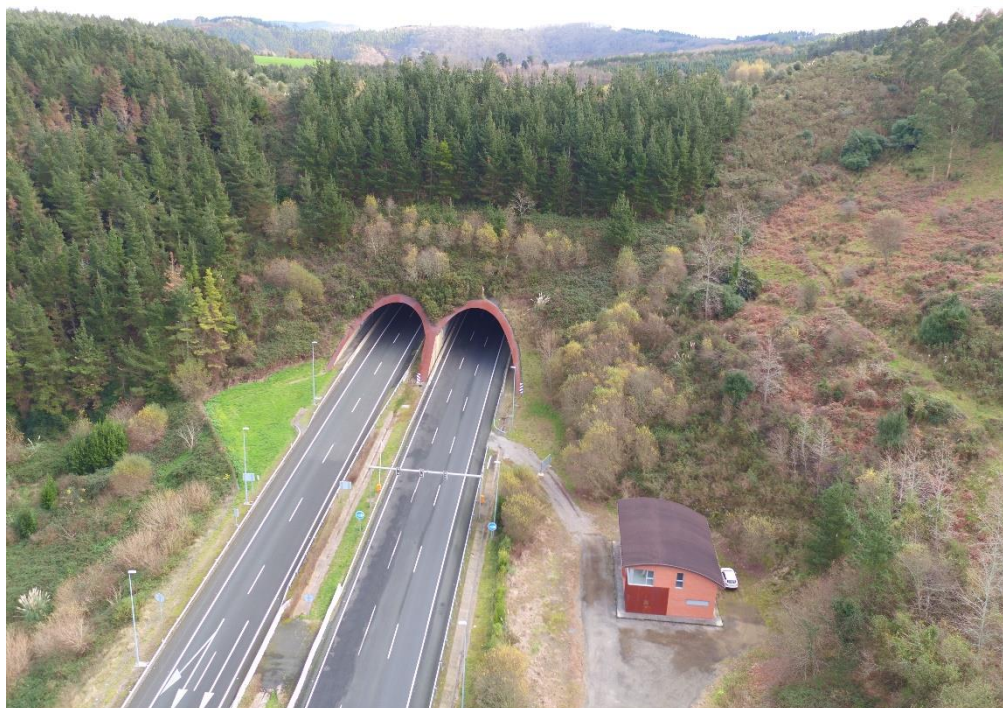
Túnel de Caviedes A-8 (pk 255+250)
