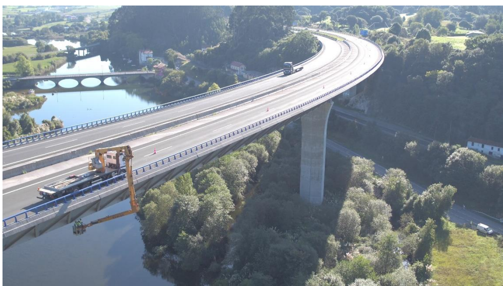
Inspecciones A-8. Viaducto de Tina Menor
