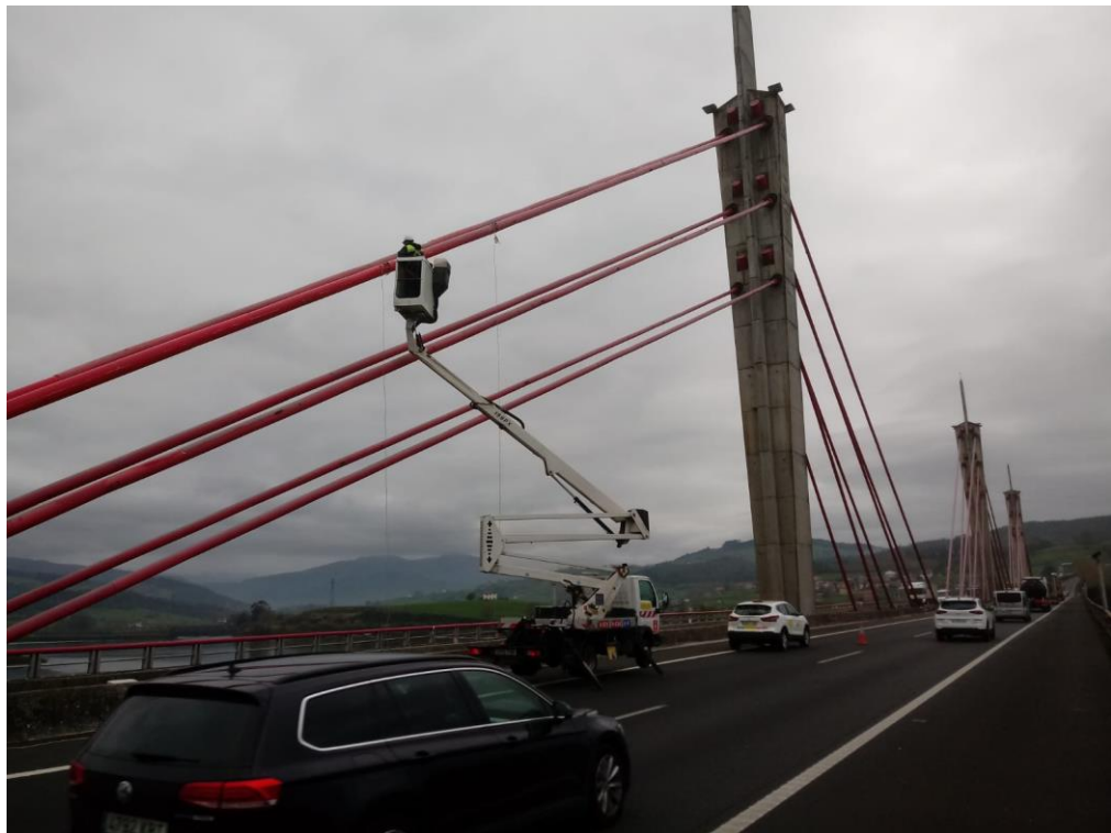
VIADUCTO DE COLINDRES A-8 P.K. 174+850
