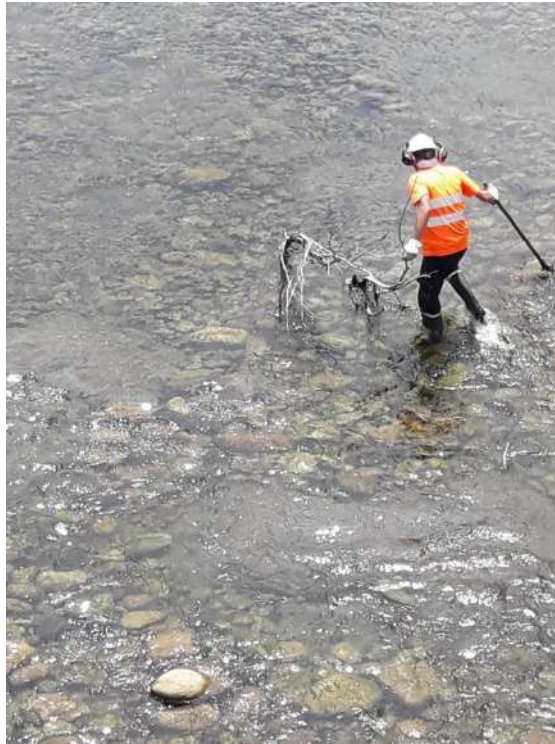
Retirada manual de restos vegetales presentes en el cauce
