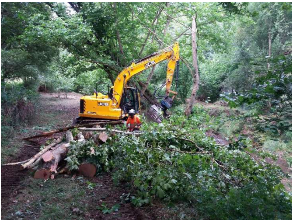
Árboles extraídos del cauce durante los trabajos
