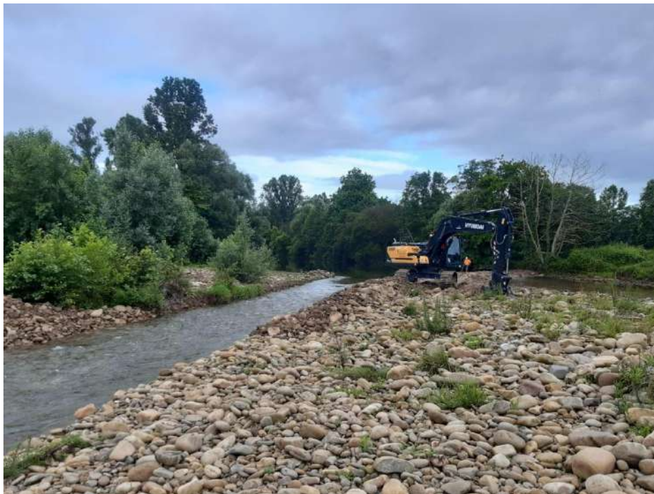
Brazo abierto en el cauce por el cual se garantizará el curso del río durante la actuación
