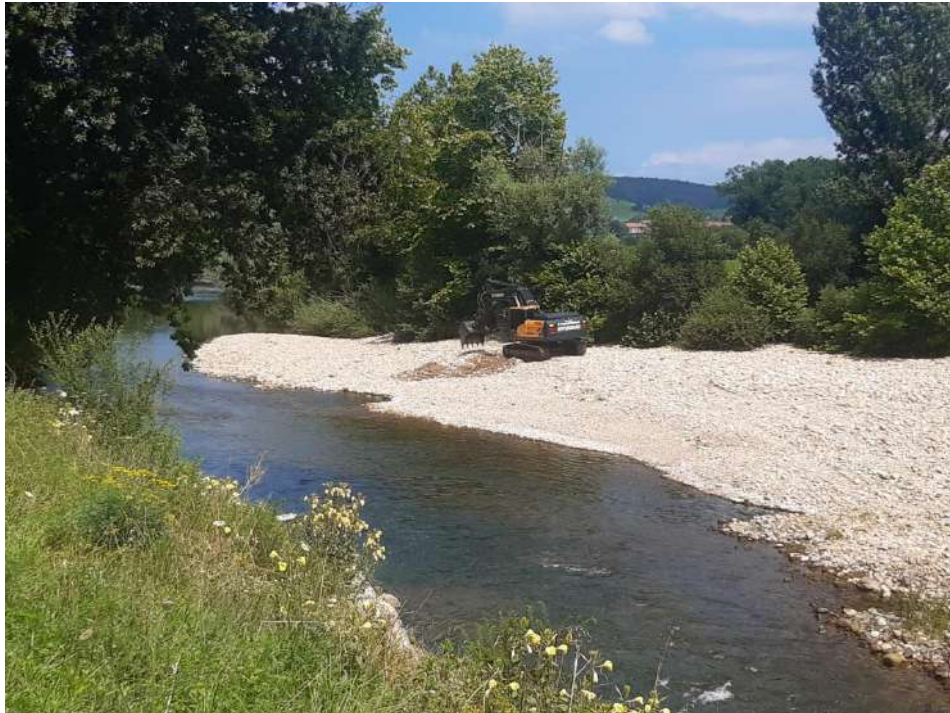
Movimiento de acarreo para habilitar un brazo en el cauce del río en la zona de la margen derecha
