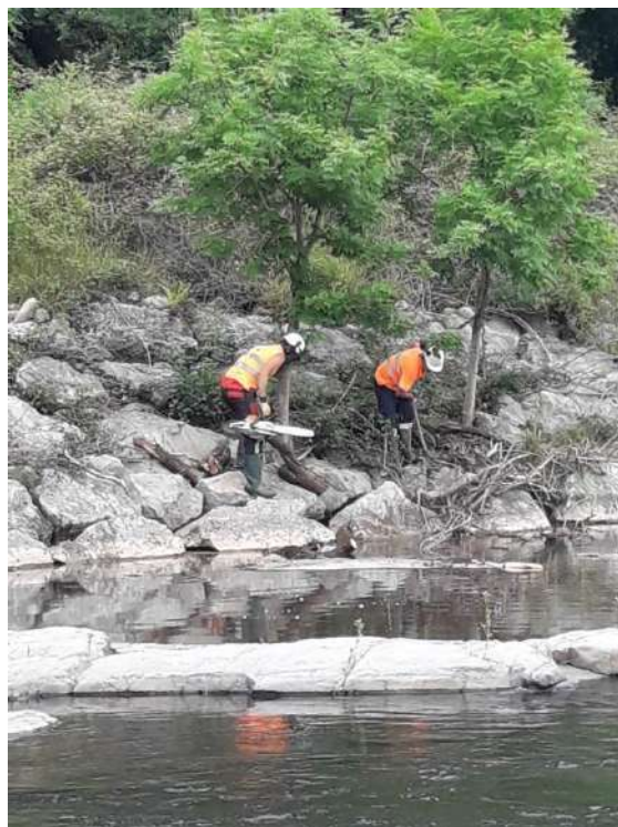
Retirada de restos vegetales en las márgenes tras haber sido troceada con motosierra
