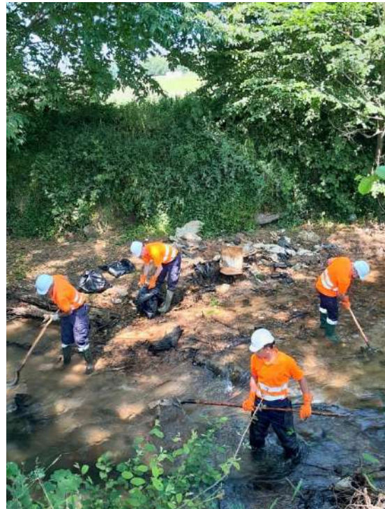
Extracción de residuos antrópicos
