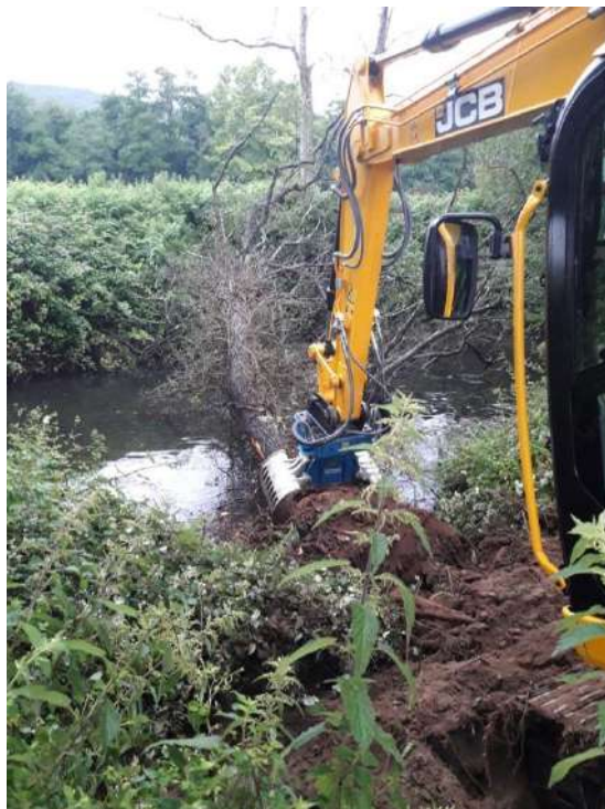
Apoyo puntual de retroexcavadora para la extracción de restos vegetales de mayor tamaño
