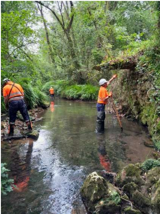
Extracción de restos vegetales del cauce
