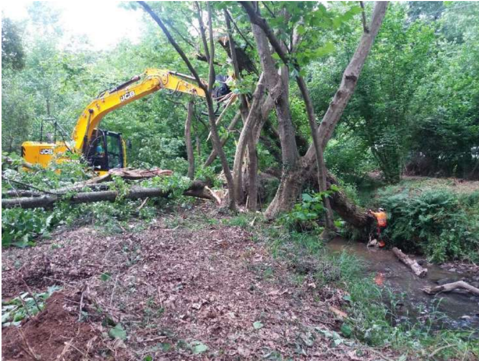
Apeo manual de árboles de gran porte y apoyo de maquinaria para controlar la caída
