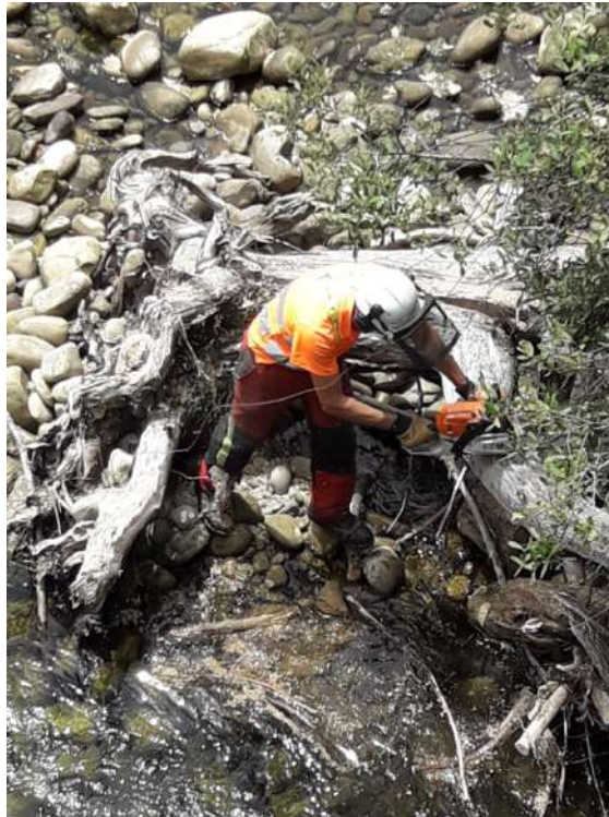
Trabajos sobre los restos vegetales presentes en el cauce
